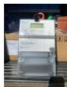
Pääkeskus ja energialaitoksen mittari A-tolpassa, mittarissa HAN-portti käytössä.
