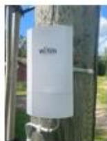
A -tolpassa Wi-Tek WI-CPE111KIT vastaanotin
